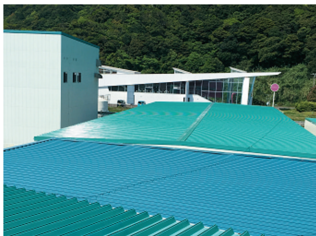
海洋深層水工場 屋根(2017年施工)
