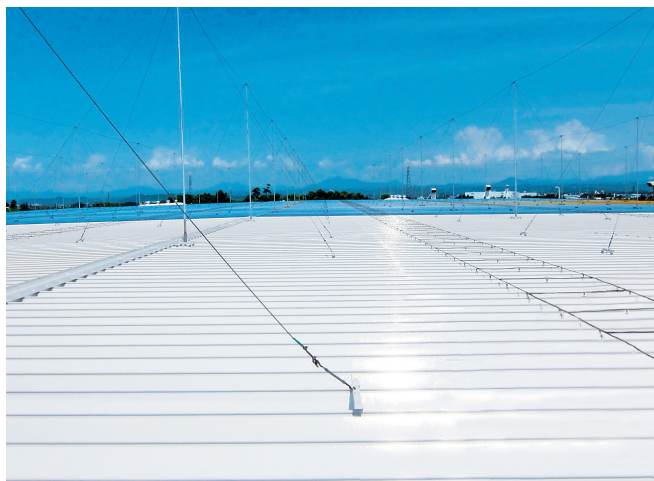
工場 折板屋根(2010年施工)
