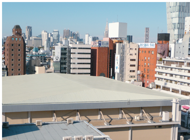
大学体育館 屋根(2010年施工)
