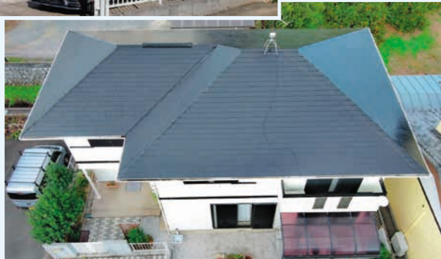
【塗替後ドローン空撮】
